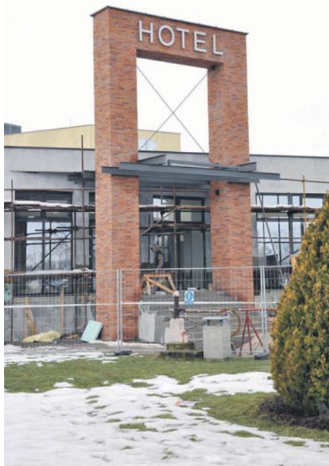
A termálfürdő főépületének átépítése a szállodai rész-szel folytatódik./Prestavba hlavnej budovy termálneho kúpaliska pokračuje v hotelovej časti objektu.
